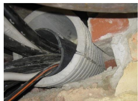
FZRG kan förses med slangklämmer för extra stöd
